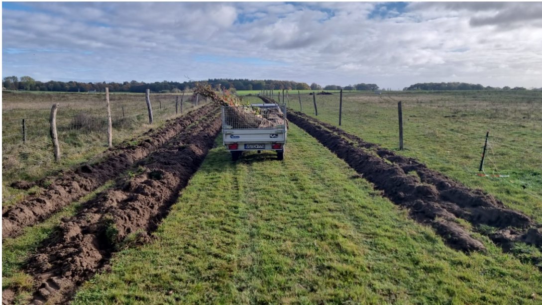
Der zweite Bauabschnitt im Oktober – fertig insgesamt
